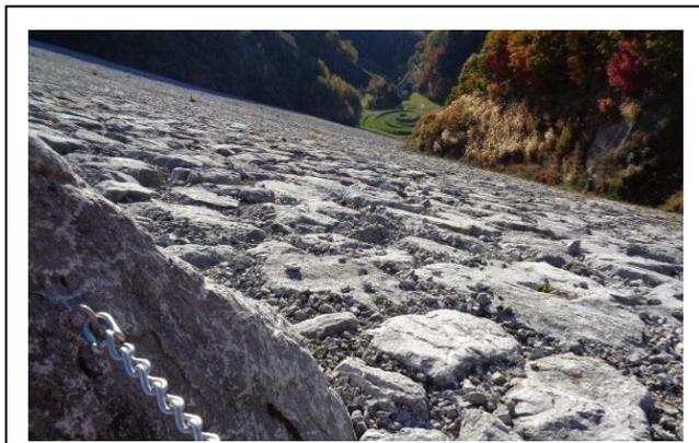
ダムに到着、このダム一見して岩石や土砂を積み上げて作られているロックフィルダム(写真:下の方に緑の広場が見える)だと分かる。2006 年に完成、堤高さ 136m とかなり高いほうだ。標高 1532m は日本で一番高いところにあるダムになっている。
