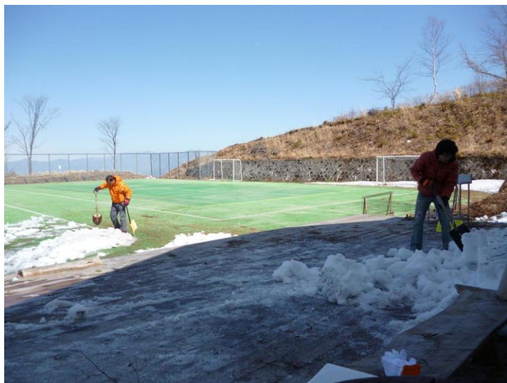
<3月21日 雪の固まりを撤去作業中>
