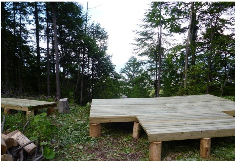
にした結果、切断は1本で1か所となり、枠組みに3本と1本を半分にしたもの使い(3本半)、テラス部分は、10本を使って約1cmの隙間を設けて75mmのコースレットでネジ止めして完成させた結果、縦99cm×横182cm×高さ13cmの大きさになりました。
