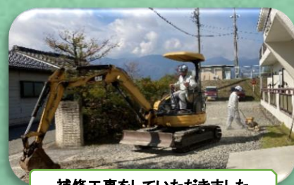
補修工事をしていただきました
