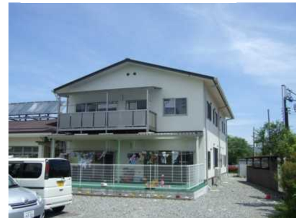
↑ 新たに建てられたショートステイ 棟。1 階は新しい幼児寮、2 階は ショートステイ用の居室。
